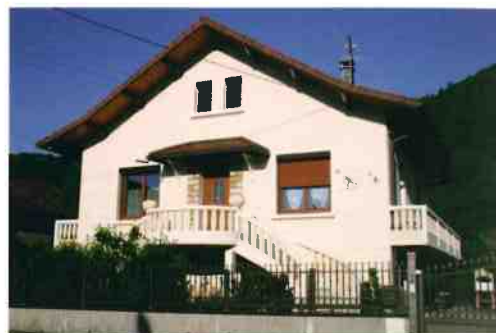
Un exemple de rénovation de façades, rue du Jura
