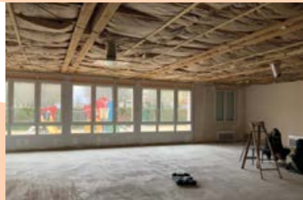
Le site Douglas( ex école maternelle) se transforme pour sa nouvelle vocation. Tout proche du bâtiment des Centres de Loisirs enfants et ados, la nouvelle salle d'Activité avec cuisine pourra accueillir 70 à 80 personnes pour les fêtes de familles !
