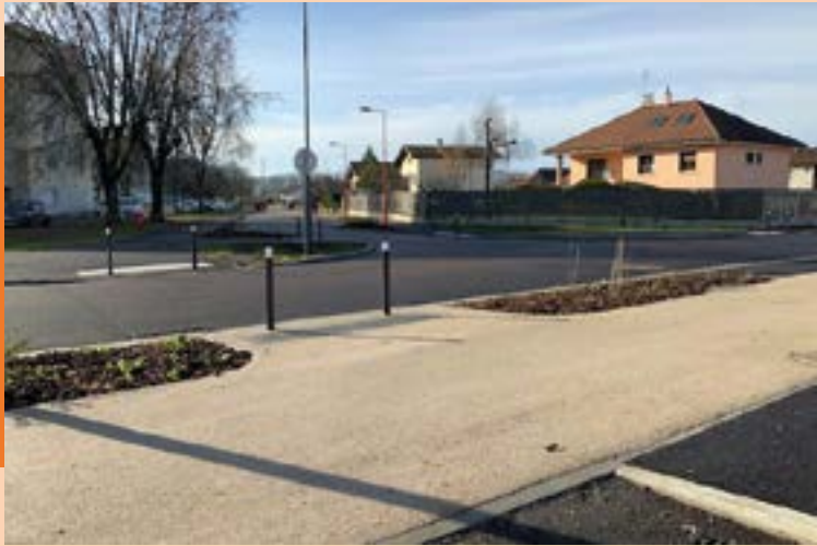
Les rues du Lange et des Narcisses, des espaces partagés destinés à la circulation de plusieurs modes de déplacement.
